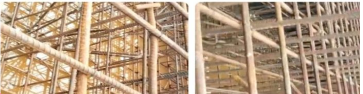
Proyek Jembatan Gantung
